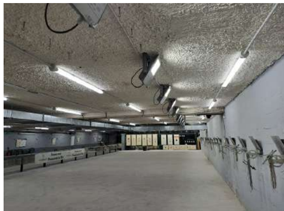
▲ Remplacement de l'éclairage du stand de tir
