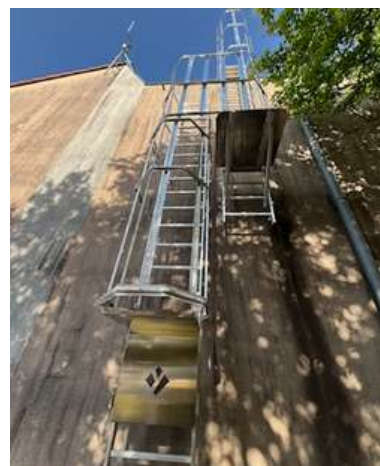
▲ Installation d'une échelle à crinoline à l'Espace Aragon
