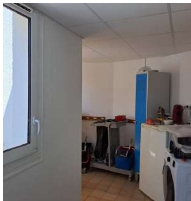
▲ Réfection des peintures et des faux plafonds de l'école des Boutons d'Or
