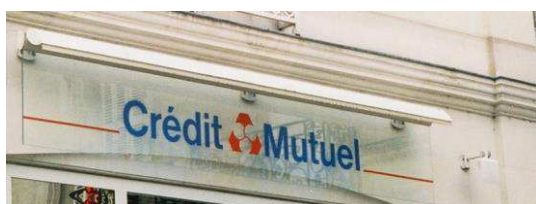
Eclairage par rampe lumineuse autorisé
