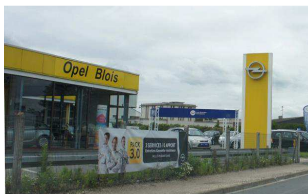
Enseignes sur clôture
